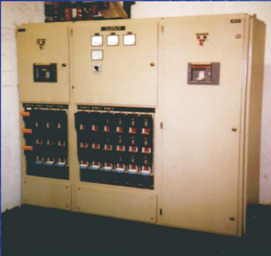
Slobodnostojeći razvodni ormari su opremljeni glavnim prekidačem sa elektromagnetskom i termičkom zaštitom, te u odvodima rastavljačko-osiguračkim prugama. Moguća su i rješenja bez prekidača na dovodu sa direktnim kablovskim ili sabirničkim priključkom na sabirnice u NNRO.
